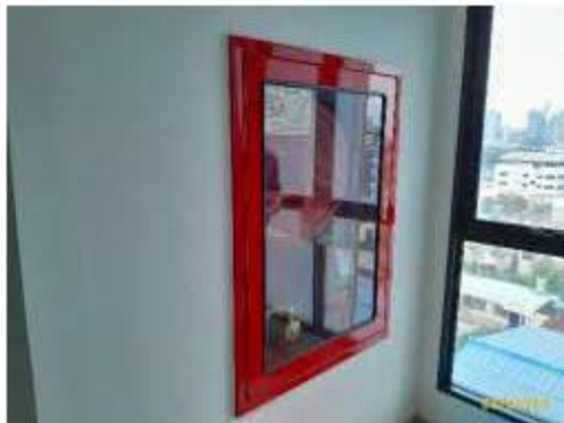
ตู้เก็บสายฉีดน้ำดับเพลิง พร้อมป้ายแนะนำวิธีการใช้อุปกรณ์
